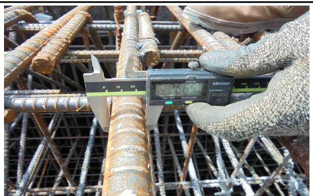
철근 배근 현황
