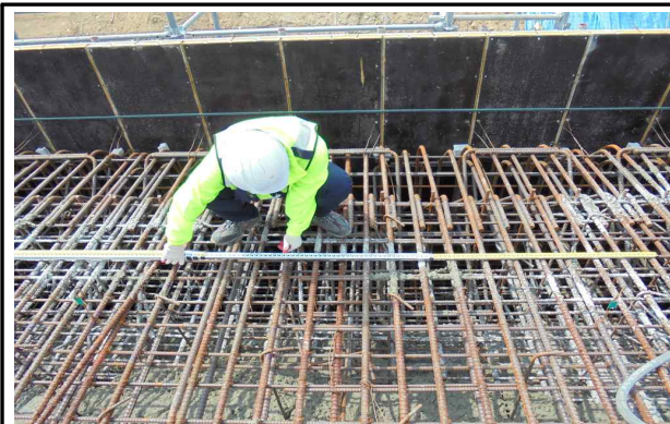
철근 배근 현황
