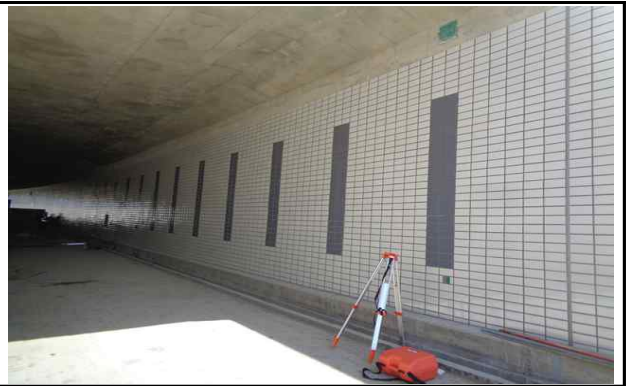
측벽 타일 전경
